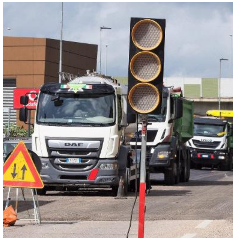
Manutenzioni stradali, a Montemurlo al via ad una serie di importanti lavori
